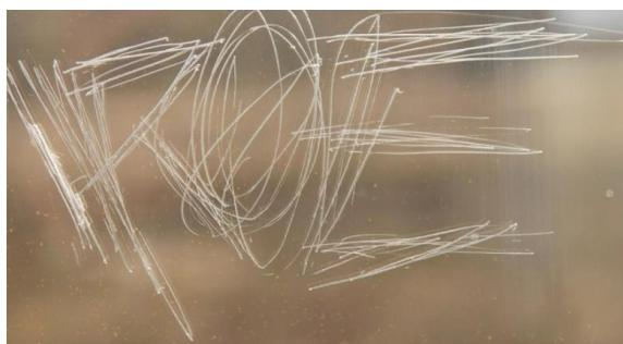
Рис. 4. Граффити вида «scratching» / «scrabbing» («скрэтчинг»/ «скрэбинг»).
